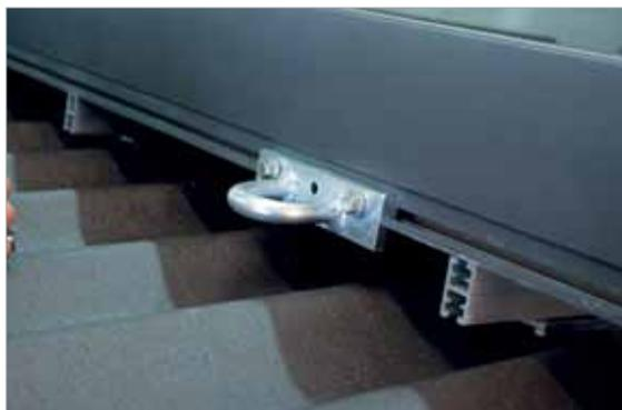
11. Obere Haltewinkel am Kollektor verschrauben (Schraube M8 und Beilagscheibe) (6.2)
