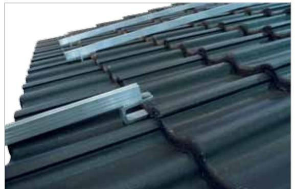
6. Untere Haltewinkel 70 x 70 mm (5.2) mittels Gleitmutter, Schraube M8 und Beilagscheibe am Vertikalprofil befestigen
