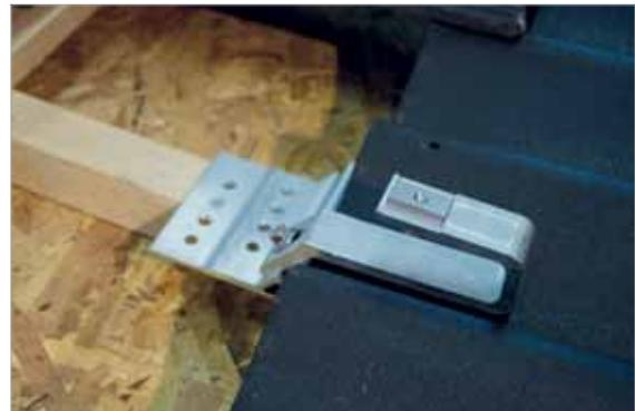
3. Dachziegel ggf. mit Trennschleifer aussparen, Dachziegel wieder positionieren.
