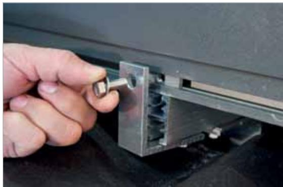
9. Obere Haltewinkel 70 x 70 mm (5.2) mittels Gleitmutter, Schraube M8 und Beilagscheibe (6.2) am Vertikalprofil befestigen
